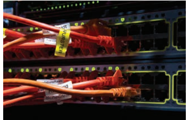
Erikoismuodot ja -materiaalit johtojen merkitsemiseen: pysty- ja vaakasuorat merkintätarrat, itselaminoituvat kaapelitarrat ja kutistesukat
